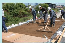
▶ 目地は板目地とし舗設の段階で設置(瀝青繊維質目地材)
