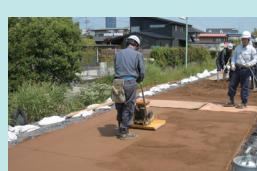
▶ プレートコンパクターにて転圧、締固める。
