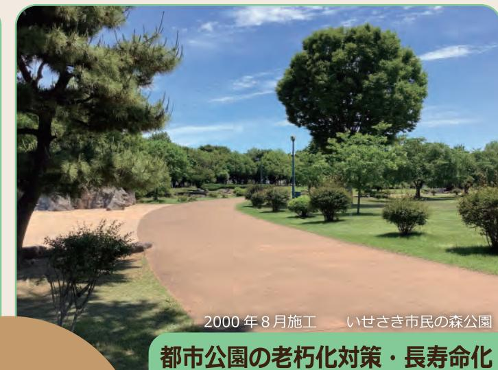
骨材の持つ潜在水硬性により耐用年数は15年～20年以上、舗装機能・透水保水機能を維持します。
