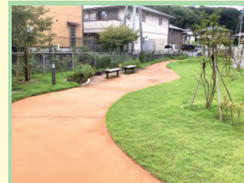
● UR 御船町一丁目地区災害公営住宅 (熊本県)
